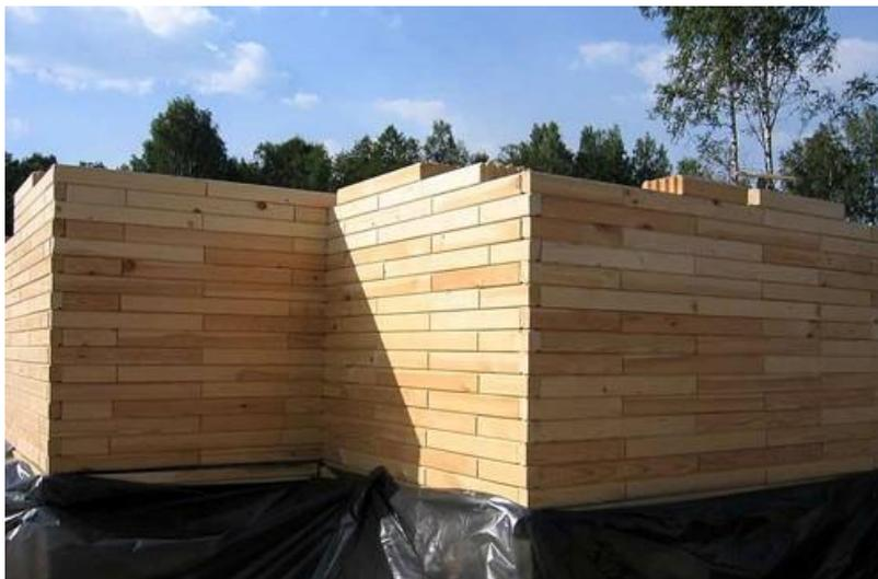
Рисунок 5 – Фрагмент здания из деревянных блоков компании «Стинком»
